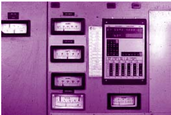
Realizacija regulacije parnega kotla z doma razvitim večznančnim mikroračunalniškim regulatorjem
