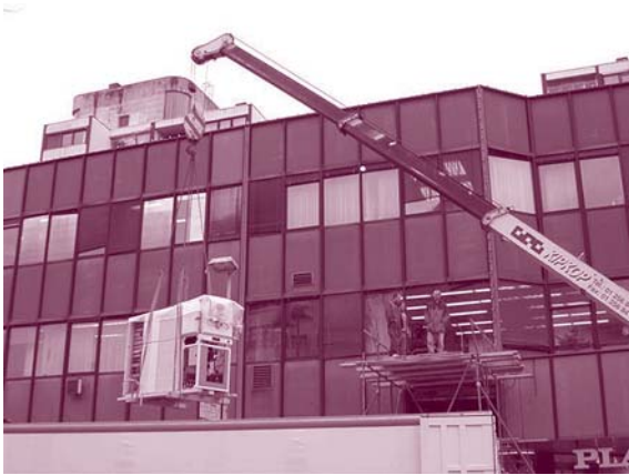
Slika 4. Transport naprave z avtodvigalom v prvo nadstropje poslovno-stanovanjske zgradbe v Domžalah, kjer je Center za trde prevleke
