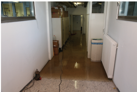
Hodnik v kleti glavne stavbe
