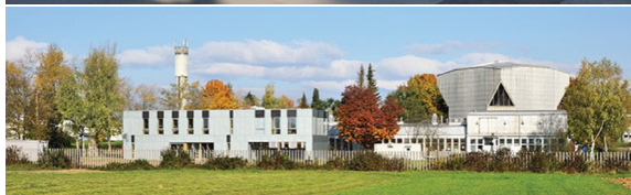
Slika 2: Slika zgoraj: Projekt je združil zgradbo, v kateri so stari prenovljeni prostori (levo) z novo poslovno stavbo (desno). Slika spodaj: Pogled na reaktorski center z južne strani.
