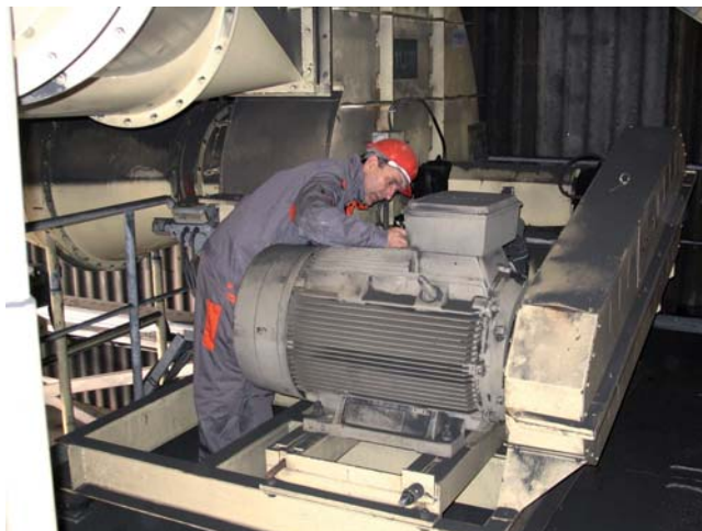
Slika 2: Izvajanje energetskega pregleda
