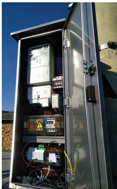
Slika 3: Merilnik sinhrofazorjev (rdeč krog), nameščen v realnem okolju na stebru transformatorja. Razvito v okviru projekta 7. OP SUNSEED.
