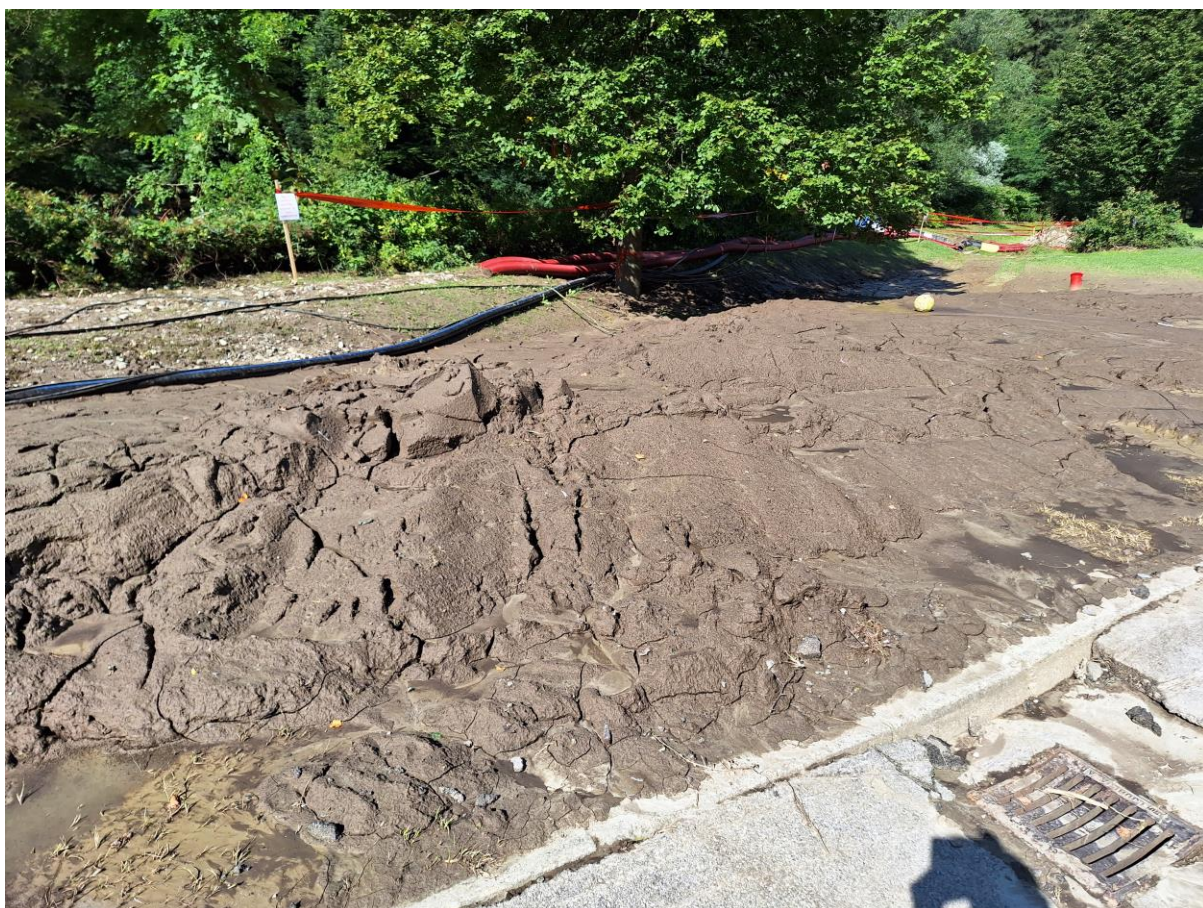
Naplavine z uničeno električno, vodovodno in drugo napeljavo na Dobrijah pri Ravnah na Koroškem.
