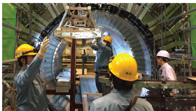
Slika 3: Namestitve kremenovih sevalnikov za detektor TOP
