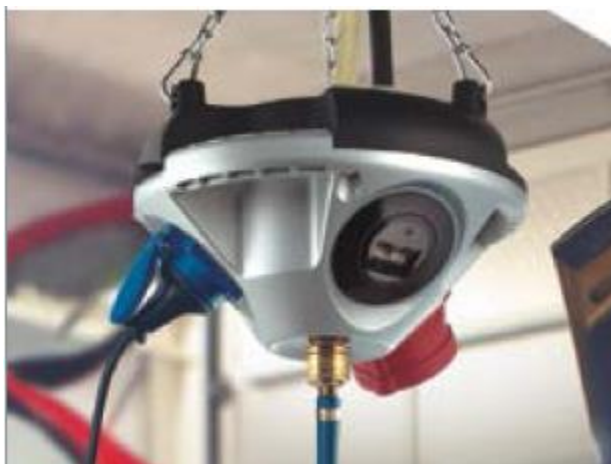
Slika 1: Viseča vtičniška omarica z vtičnicami 230V, Internet priključkom RJ45 in kompromiranim zarkom
