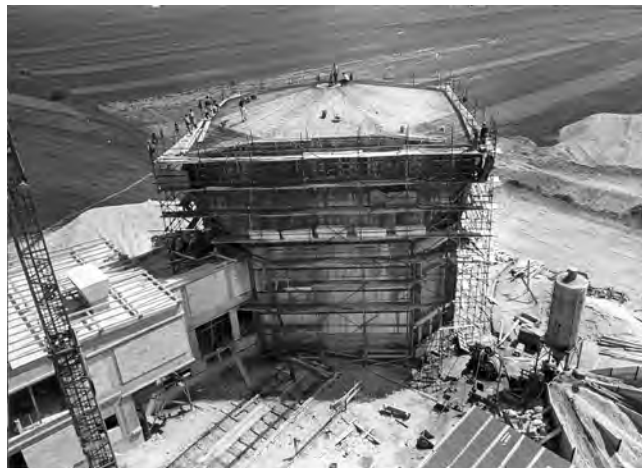
Reaktorski center, Podgorica, zgrajen leta 1966
