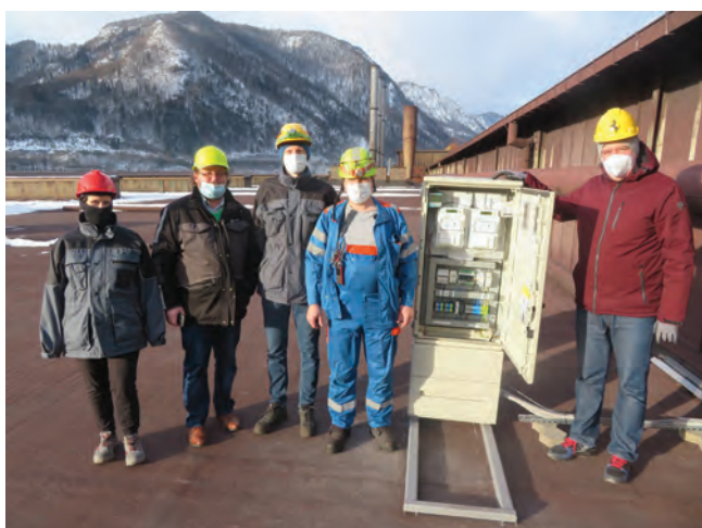
Slika 3: Testno polje za oceno potenciala izkoriščanja sončne energije na strehi obrata SIJ-Acroni v okviru projekta CREATORS
